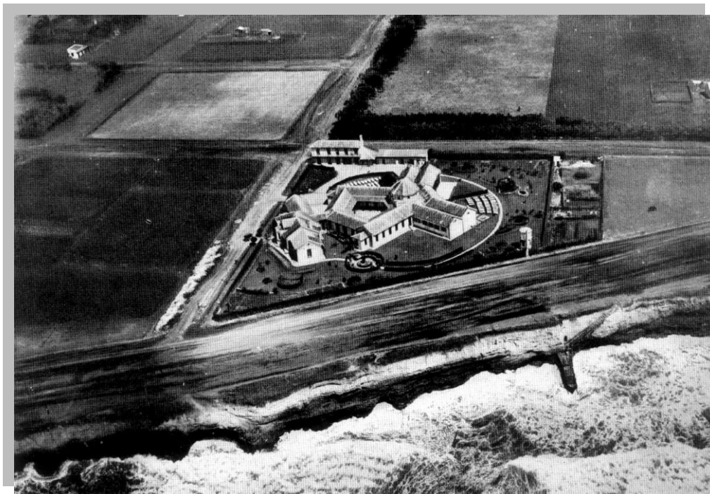
Solarium del Sanatorio Marítimo
